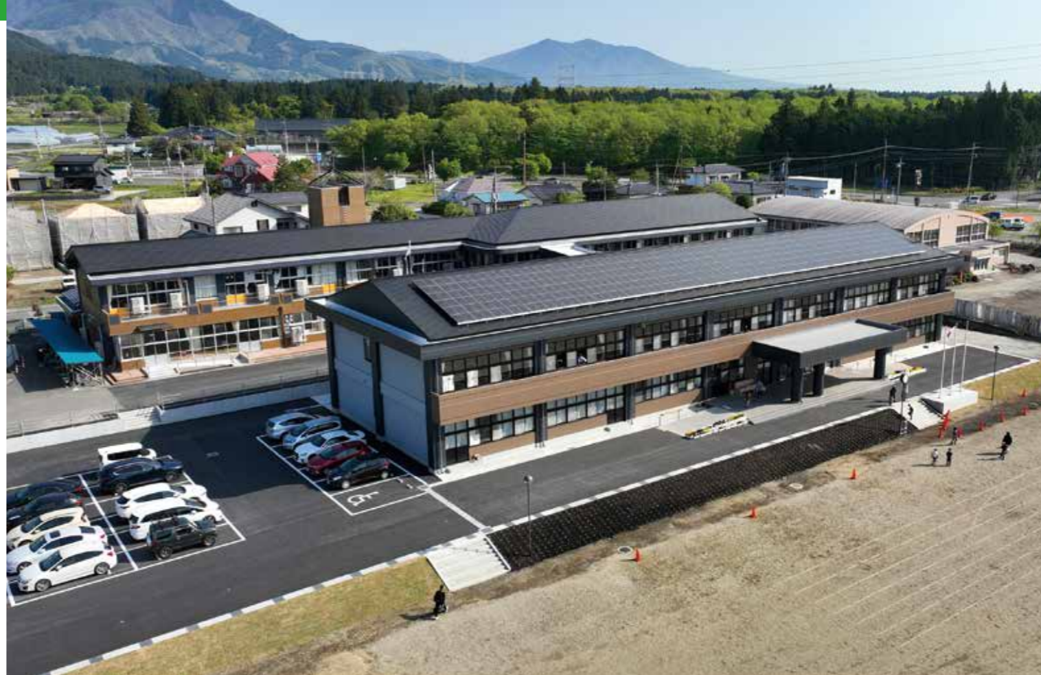
旧関谷小学校敷地に建設された箒根学園校舎。手前が新校舎、奥が旧関谷小の校舎で、2つの校舎を渡り廊下でつないだ。新校舎には太陽光発電パネル、蓄電池システムが設置され、停電時でも学習環境が維持できるようになっている。
