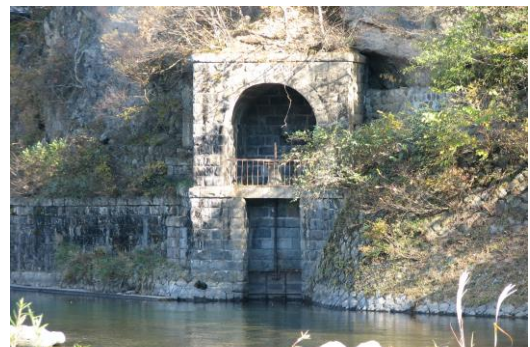
旧西岩崎取水口
